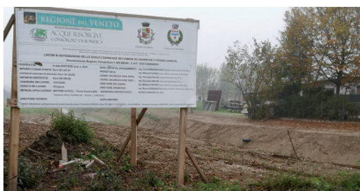
Il cantiere del Consorzio di bonifica Acque Risorgive a Cadoneghe.
